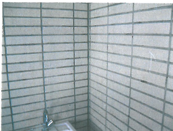
Bild 7: Fugendichtmasse, Raum 126
