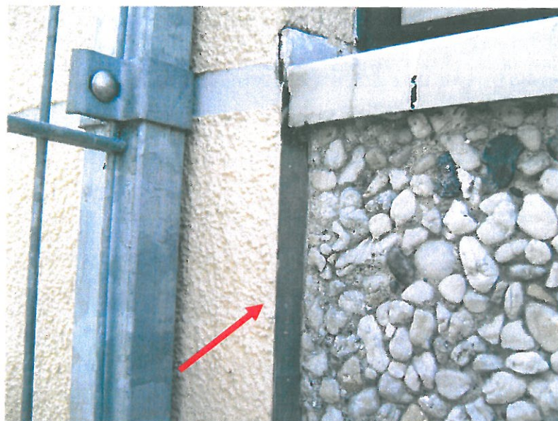
Bild 15: Dichtmasse
