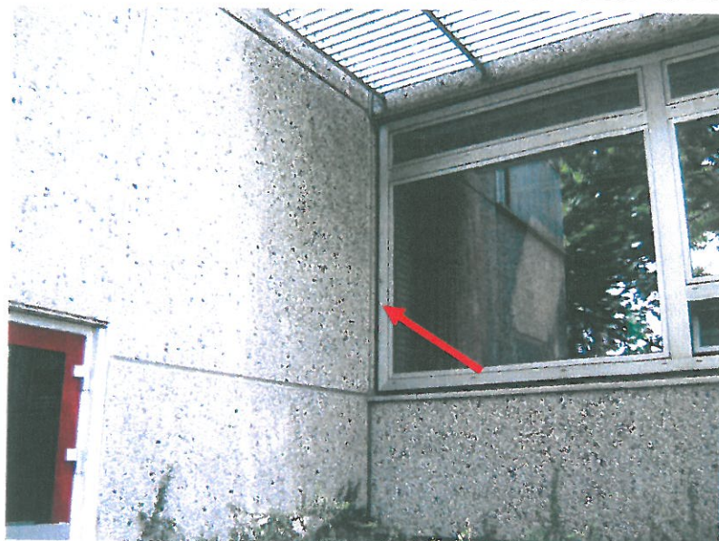
Bild 16: Fensterabdichtung, Achse 16
