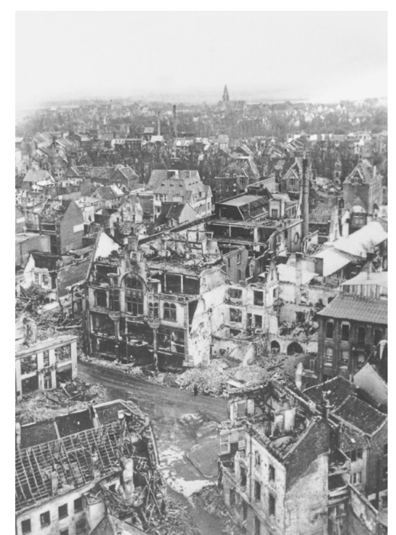
Les ruines de l'hôtel de ville détruit lors du raid aérien de 1944 vues de la cathédrale, avec la caisse d'épargne municipale (à droite) et le grand magasin Rud. van Endert (à gauche), 1945.
