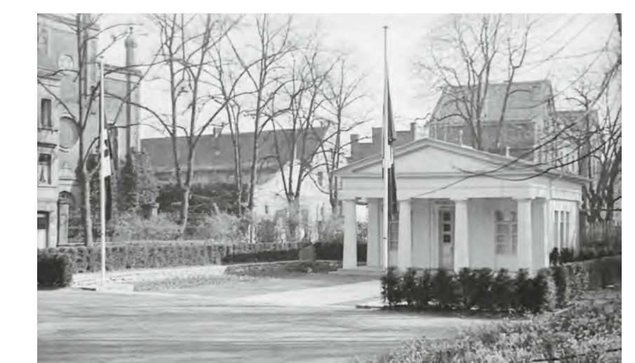
Das ehem. Scheibenhäuschen an der Promenade, in dem zeitweise auch die jüdische Schule untergebracht war, links die zurückgesetzte Fassade der Synagoge, um 1935
