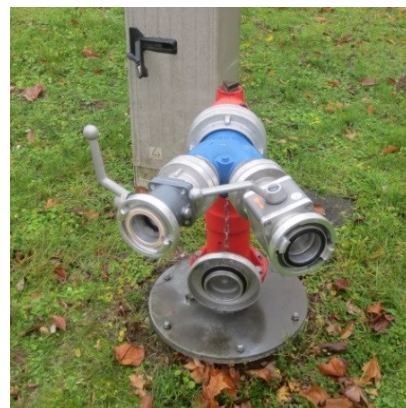
Sammelstück mit 2 B-Absperrventilen
