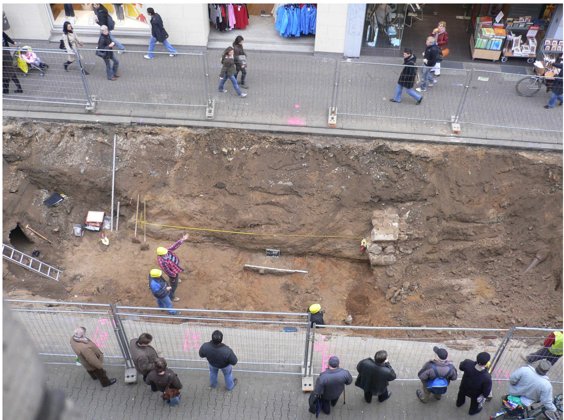
Ostprofil des Niedertores in der Baugrube
