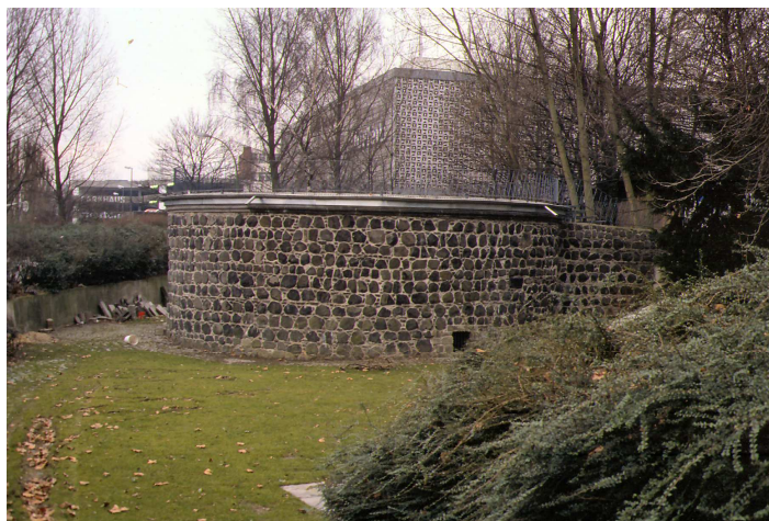
Der Kehlurm. Ansicht aus dem Jahr 1990 vor dem Bau des Romaneums
