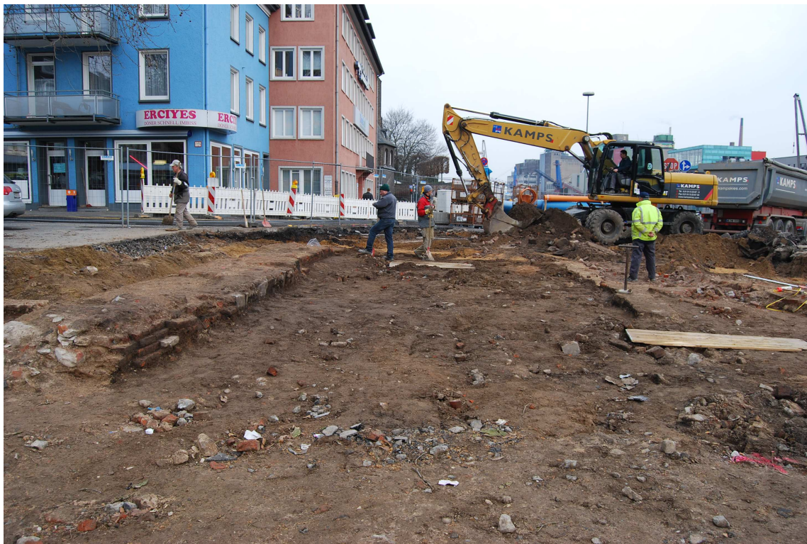
Abb. 14 Verlauf der alten Brückstraße, Blick nach Norden (links Ostmauer der Sepulchrinerinnenkirche, rechts Umfassungsmauer des Alexianerklosters und des Schlachthauses
