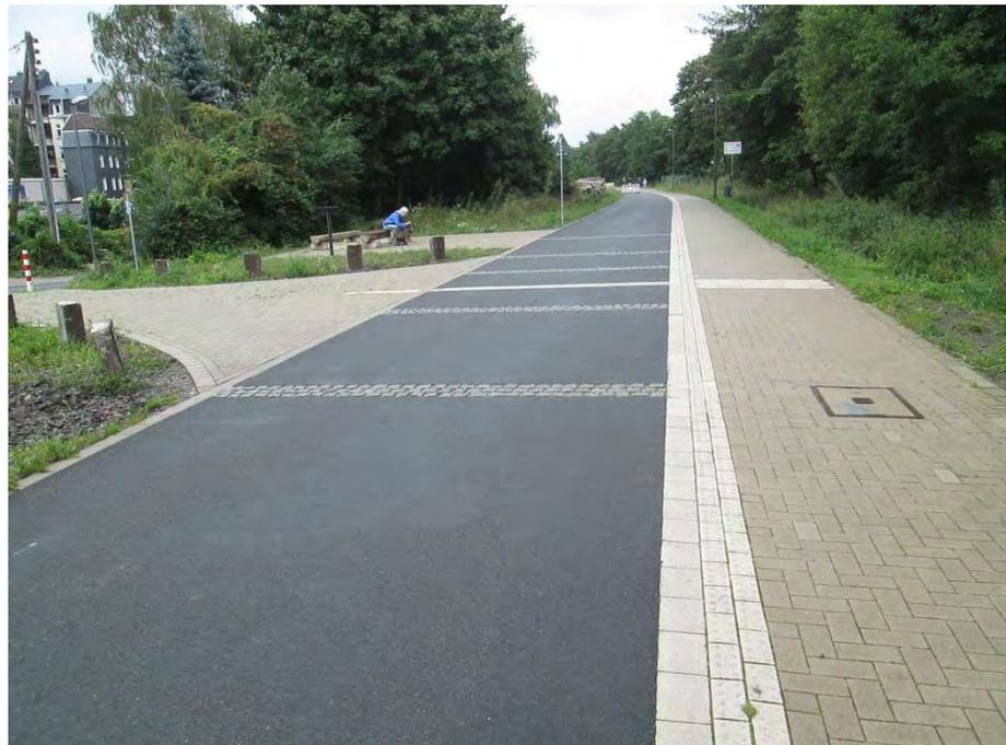
*Abbildung 2-10: Trennung zwischen Fuß- und Radverkehr auf der Nordbahntrasse Wuppertal*
