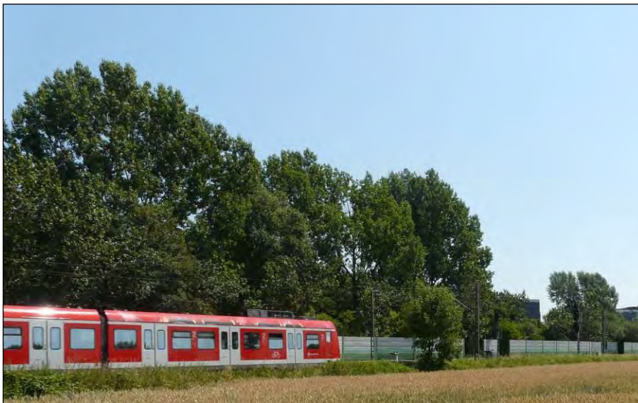
Abbildung 4-8: die realisierte SSW in Erfttal
