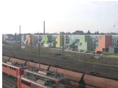
Abbildung 3-4 : Wohnbebauung am Güterbahnhof mit vorgesetzter Schallschutzfassade
