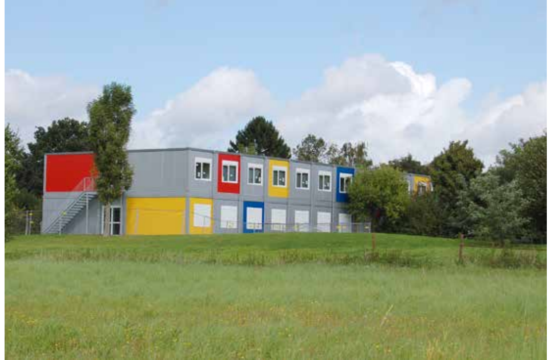
Die Wohncontainer, die ursprünglich für die Unterbringung von Flüchtlingen gedacht waren, bieten eine gute Alternative
